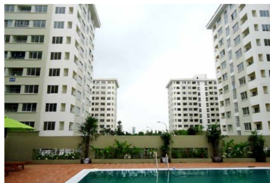
Khu nhà ở cho người thu nhập thấp tại KĐT Đặng Xá vừa được hoàn thành
